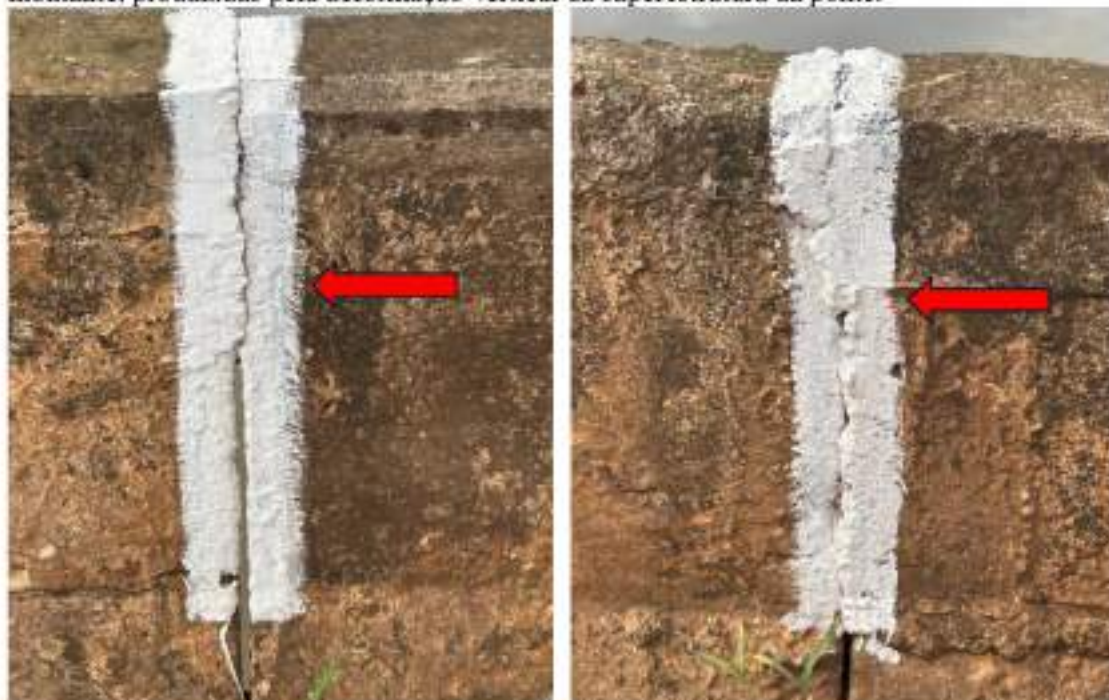
Figuras 03 e 04: Ilustram juntas de dilatação sem espaço, nas barreiras rígidas do lado montante, produzidas pela deformação vertical da superestrutura da ponte.
