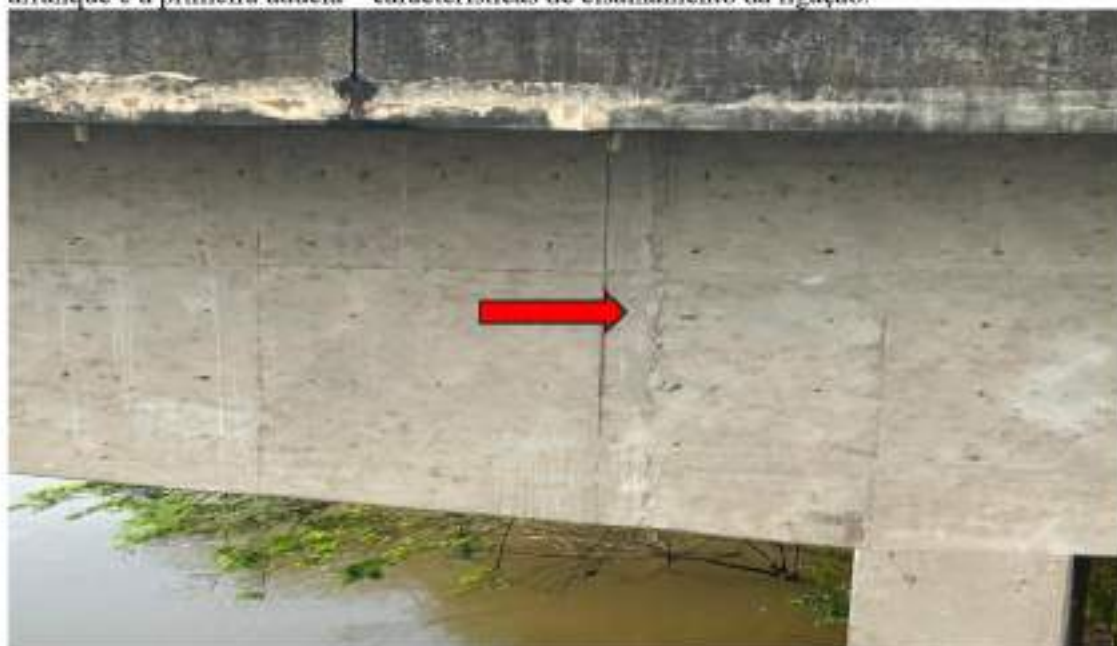
Figura 09: Ilustra fissura na lateral da viga caixão, lado jusante, na ligação da aduela de arranque e a primeira aduela – características de cisalhamento da ligação.
