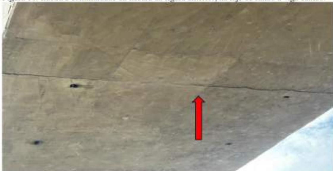
Figura 10: Ilustra a continuidade da fissura da figura anterior, na laje de fundo a viga caixão.
