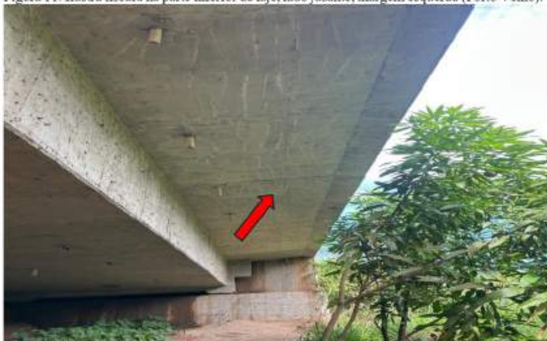
Figura 11: Ilustra fissura na parte inferior da laje, lado jusante, margem esquerda (Porto Velho).
